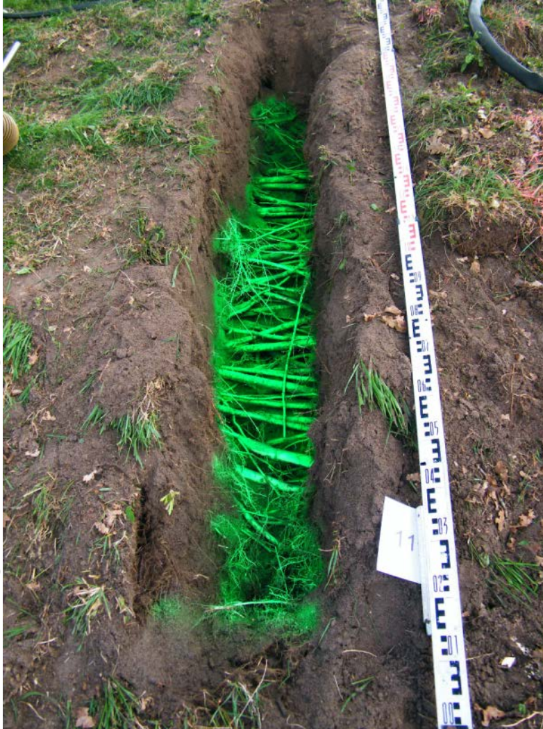
Suchschachtung Dammkrone mit Hagen Baumbüro GmbH
