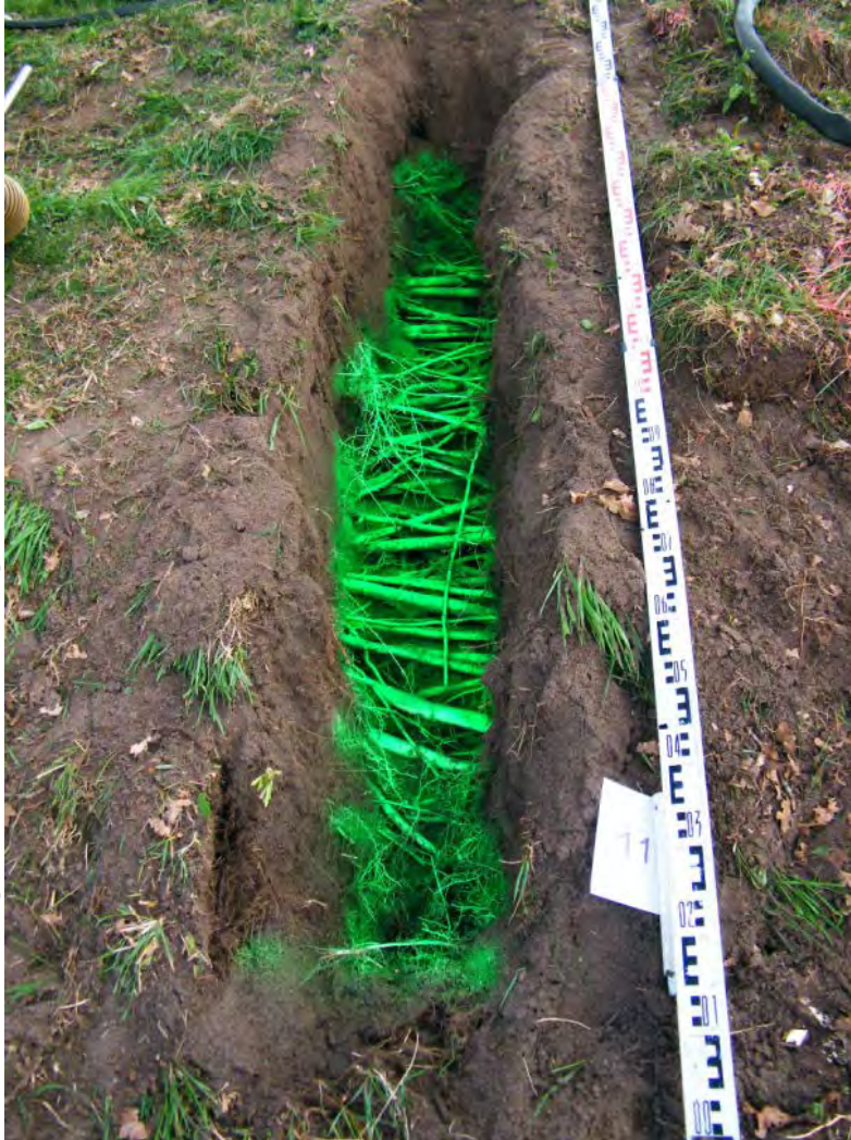
Suchschachtung Dammkrone mit Hagen Baumbüro GmbH
